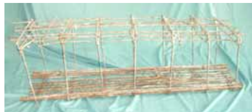
写真-1 第4径間G1 全体
