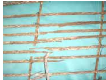
写真-2 第4径間G1 最劣化部
