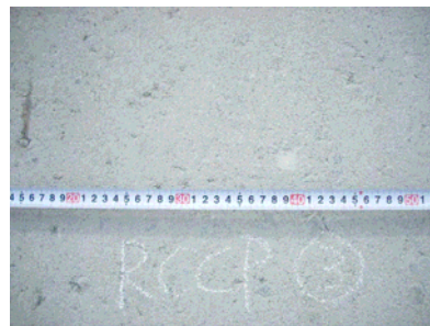
図-3 仕上がり状況 (再生 100%)
