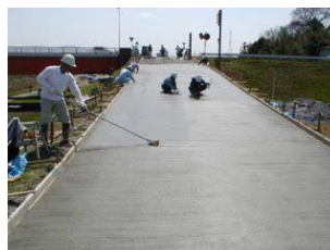
写真-3 粗面仕上げ
