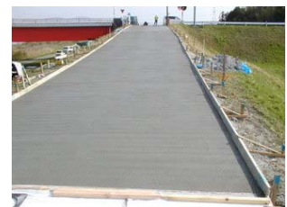
写真-4 施工直後
