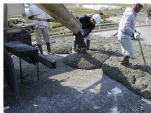
写真-2 敷きならし・締固め
