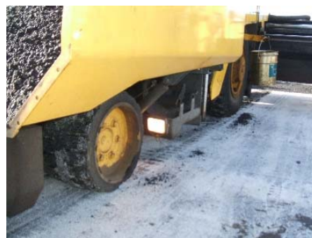
写真-1 合材敷均し状況 (フィニッシュオイルに付着なし)
