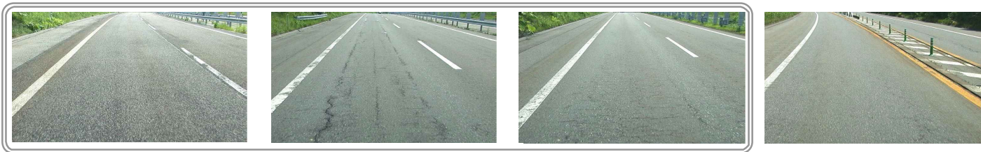
写真2 断熱材工法 (t=5 cm) 上り線 写真3 断熱材工法 (t=10 cm) 上り線 写真4 置換工法 (100 cm置換) 上り線 写真5 断熱材工法 (t=5 cm) 下り線
