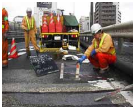
写真-1 施工状況写真の例
