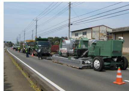
写真-1 ヒートスティック工法の施工体制
