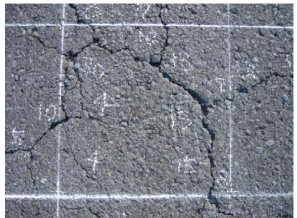
写真-1 ひび割れの幅の記録
