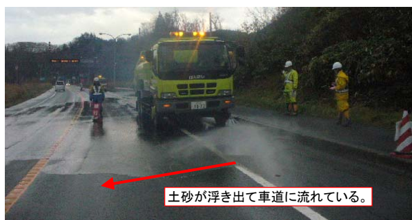
写真-1 清掃時に土砂が車道に流出している状況
