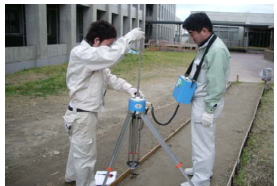
写真-2 簡易支持力試験
