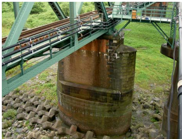
図3 計測対象橋脚の状況
