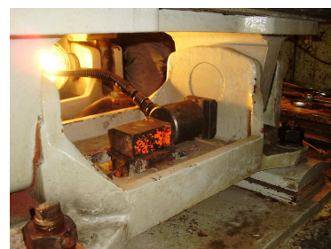
図2 シュー座の移動による補修作業
