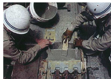
図3 目地部(上部)の補修作業
