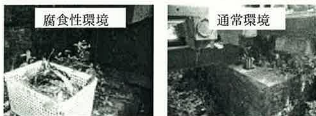
図-3. 供試体設置状況
