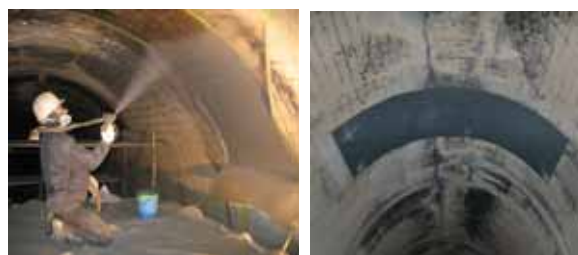
a) 作業状況 b) 施工後 図-1 吹付けウレタン工法の概要
