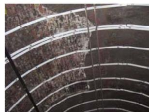
写真 3 吹付モルタルの剥離
