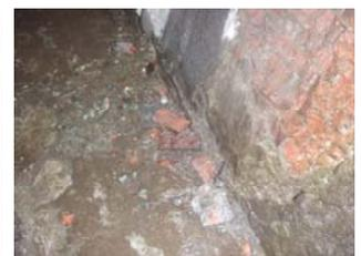
写真 4 吹付けモルタルの劣化
