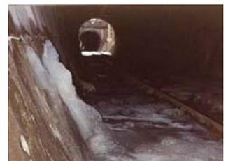
写真 2 坑口付近側壁の氷柱
