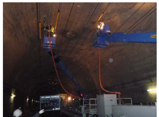
写真-3 注入状況
