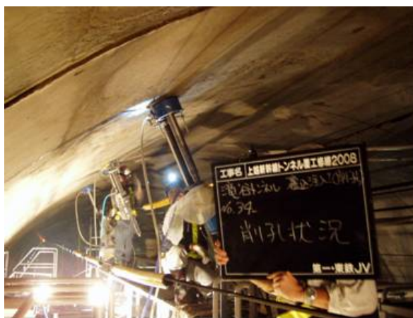
写真-2 注入用の削孔状況
