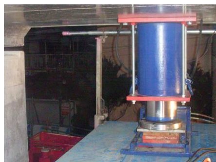
写真1：ジャッキ配置状況
