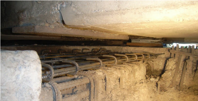
写真-3. 沓座(取壊し状況)
