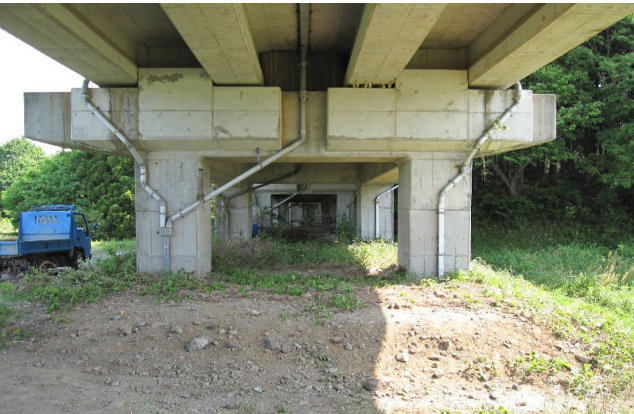
写真-1. 沓座修繕箇所の全景
