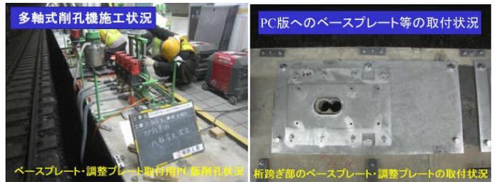
作業の効率化としては、鋼製覆工板としたことで本作業時間を拡大(30分)することができた。また、写真-6、7に示すように PC 版削孔には貫通・ザグリ・コアの削孔に 15 孔行うため、作業の効率化を上げるため削孔機の開発を行った。その結果、多種削孔・複数孔同時削孔・スライド移動機能などを備えた多軸式削孔機を開発し、複数のフレーム台座を削孔位置に事前セットし、作業の効率化(3枚/日)を図ることができた。
