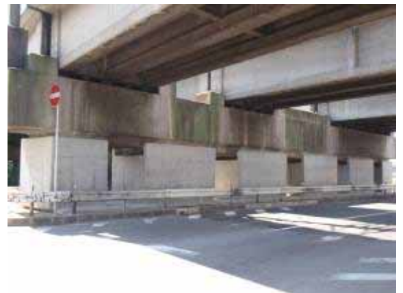
写真 - 4 施工完了全景（京葉線谷津架道橋）
