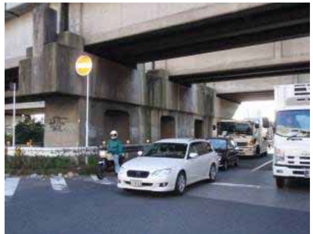
写真-1 京葉線 谷津架道橋 P2 橋脚全景
