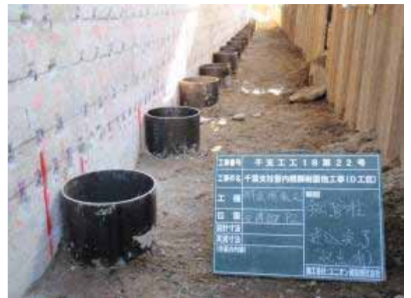
写真 - 3 鋼管配置状況（京葉線谷津架道橋）
