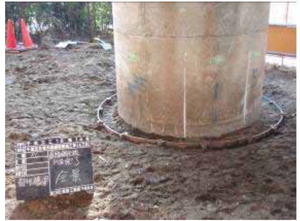
写真 - 2 直線鋼矢板施工（京葉線都川橋りょう）
