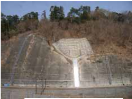
写真 3 復旧工事の状況
