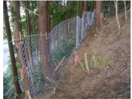
写真-4 簡易落石止さく
