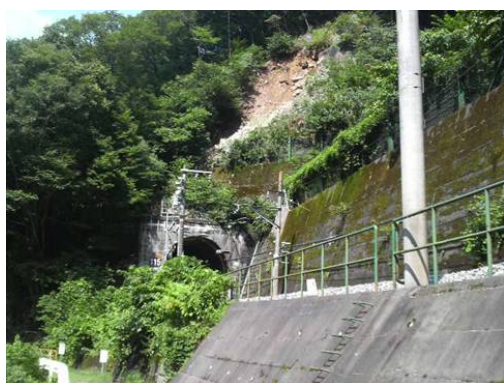
写真-1 被災箇所全景
