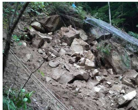
写真-2 崩壊箇所(ブロック状岩塊)
