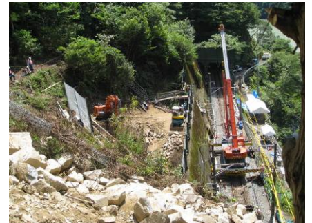
写真-3 重機による復旧
