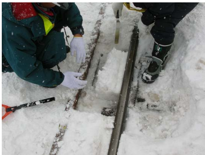
写真1 3線軌道区間での試料採取
