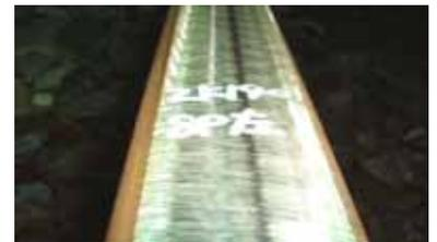
図-4 導入当初のハラスコ10頭式削正痕
