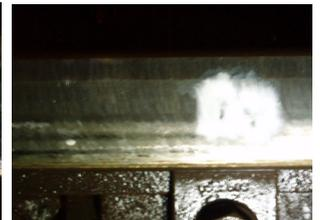
写真-2 レール頭面削正状況 (8パス後)
