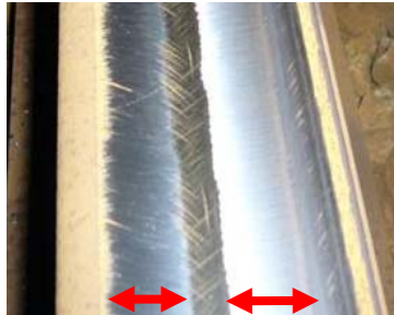
写真-6 2 パス施工後の踏面
