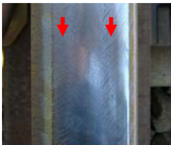
写真-5 レール踏面
