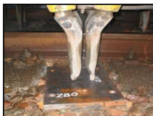
写真-2 鋼板敷設による施工方法
