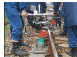
写真-1 ランマによる締固め
