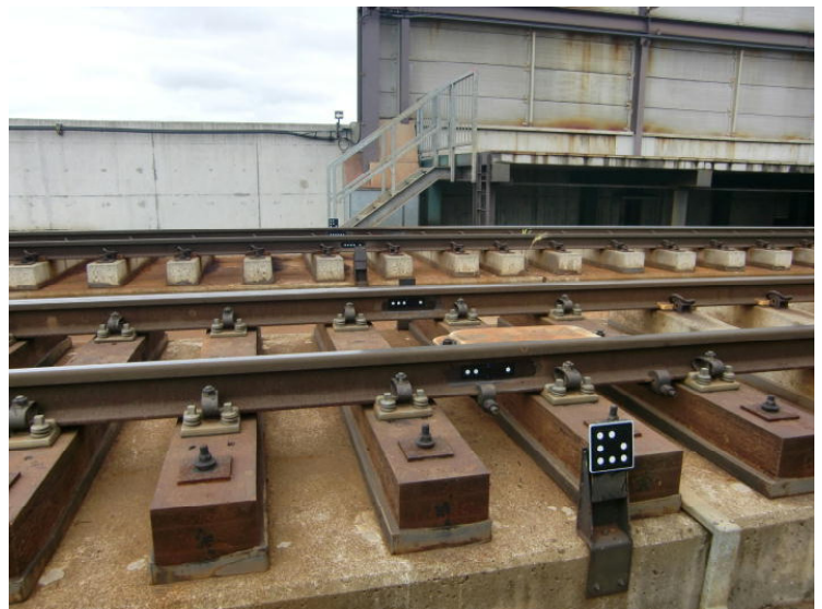
図5 ターゲット敷設状況(札沼線・八軒駅構内)
