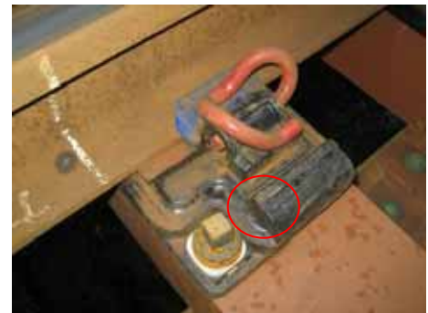
写真 - 2 応力が集中しやすい部分
