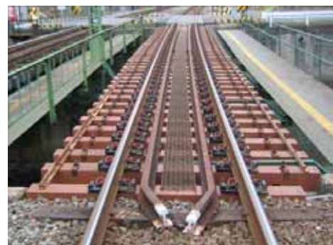
写真 - 3 試験敷設状況
