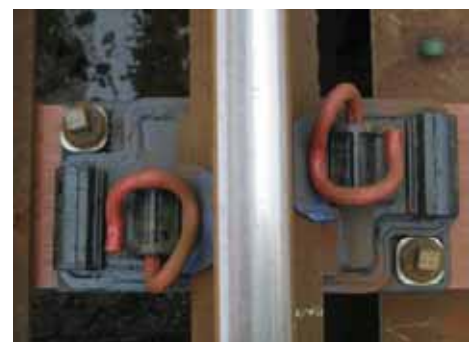
写真 - 4 レール締結装の敷設状態
