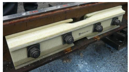
図 1 応急継目板敷設状態
