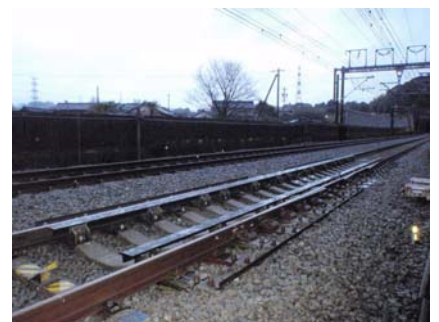
写真－5 本線試験敷設の状況
