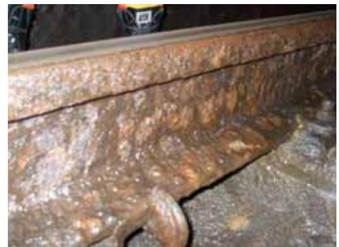
写真1 レール腐食状況
