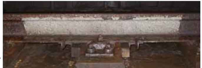
写真5 本線レールへの塗装状況(無機系防食材)
