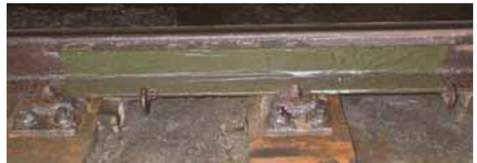
写真6 本線レールへの塗装状況(有機系防食材)
