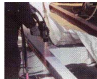
図2 溶射施工
