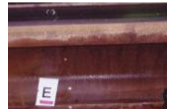
図 6 洗浄線の計器検査
