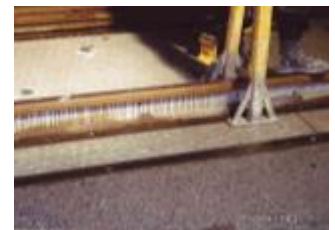
図 5 連軌の目視検査
