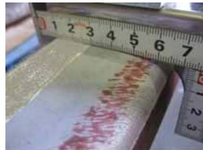
図-5 きしみ割れ測定項目
