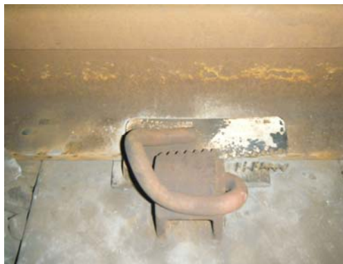
写真-5 ケプラー配合の試験後の状況
