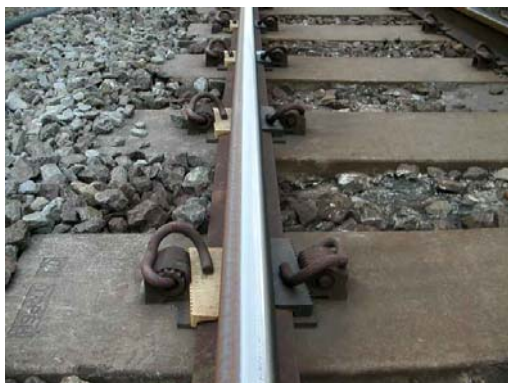
写真-4 ケプラー配合楔形インシュレーター
