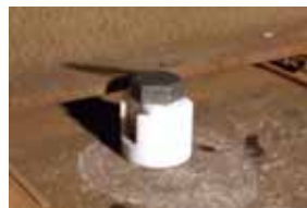
図-5 : インサート施工後
