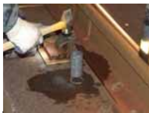
図-3 : コア抜き状況
