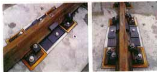
図-2: レール転倒防止装置敷設状況
