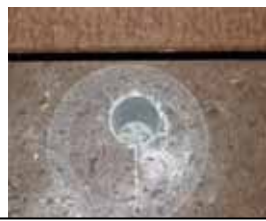
図-4 : スラブ板穿孔施工後
