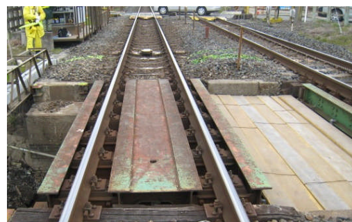
写真 1 新川橋梁（東北本線 47k645m～648m）
