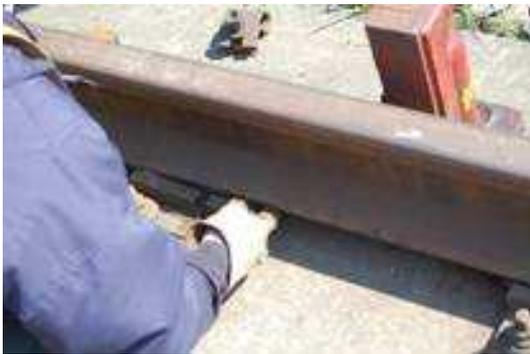
図-1 軌道パッド・可変パッド敷設
