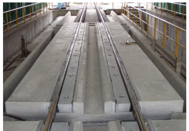
図2 敷設した新形式軌道構造
