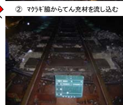
写真-5 アバット部における施工コア抜き再てん充写真
