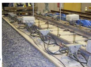
写真-1 自動切替弁ユニット及び配管
