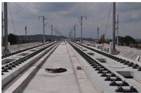
図 2-1 RC 枠型スラブ軌道
