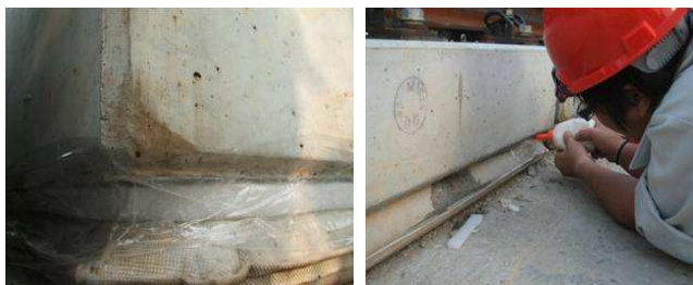
図 4-1 注入（型枠有り）
