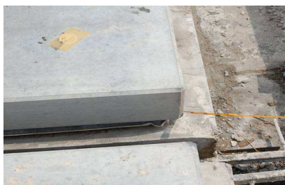
図 3-5 スラブ板と CAM の空隙
