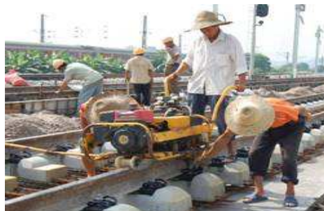
図 5-1 中国施工風景
