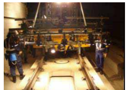
写真-1 スラブ撮像の作業状況
