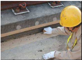
写真4-3 スラブ下面部 (CAM 部) の補修工法 (C ランク)
