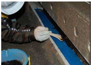
写真4-1 スラブ下面部 (CAM 部) の補修工法 (A ランク)
