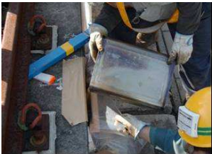
写真4-2 スラブ下面部 (CAM 部) の補修工法 (B ランク)
