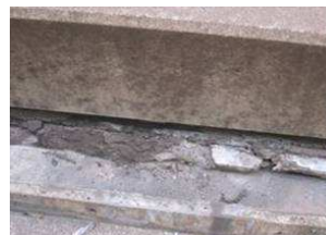
写真3-1 スラブ下面部(CAM部)
