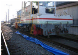
写真-3 軌道モーターカーによる载荷
