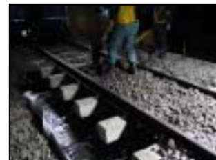
④ 軌道復旧
