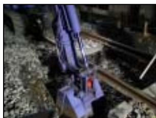
① バラスト及び路盤掘削
