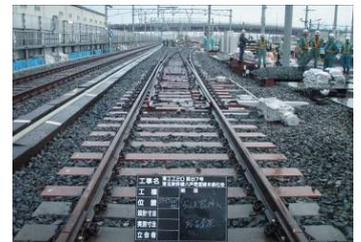
写真-7 分岐器挿入後
