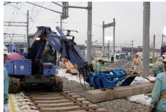
写真-4 PC マクラギ撤去状況
