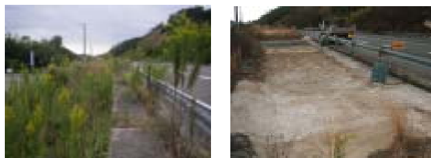
(a) 施工前 (b) 施工後
