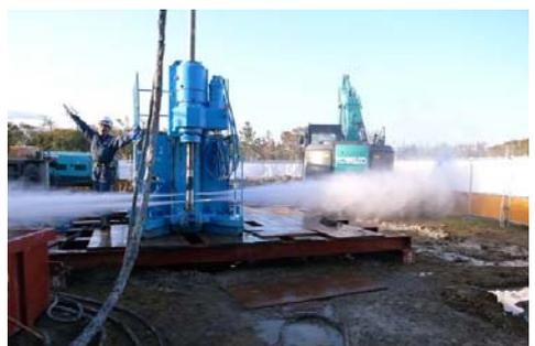
写真-2 開発した先端モニターからの噴射
