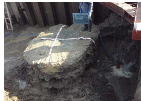
写真-4 セメントミルクを用いた改良体
