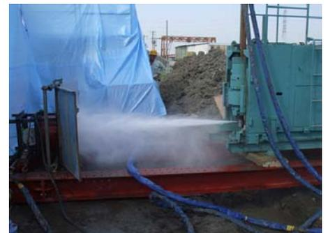
写真-1 従来の二重管ロッド式の噴射
