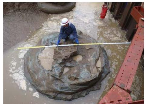
写真-3 リサイクル液を用いた改良体
